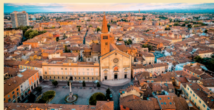
Una veduta dall'alto della Cattedrale di Piacenza che il 30 settembre vedrà la messa di beatificazione del martire don Beotti.
